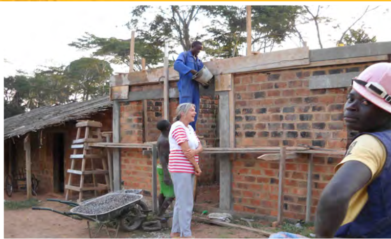
Een van de huizen in aanbouw
