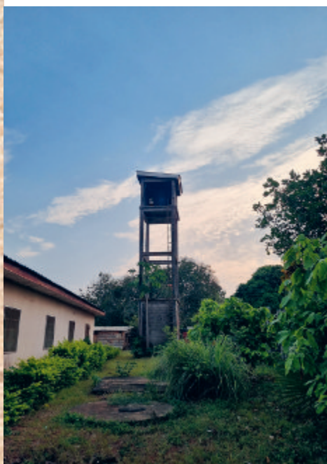
Wasser - Hochbehälter außer Betrieb
