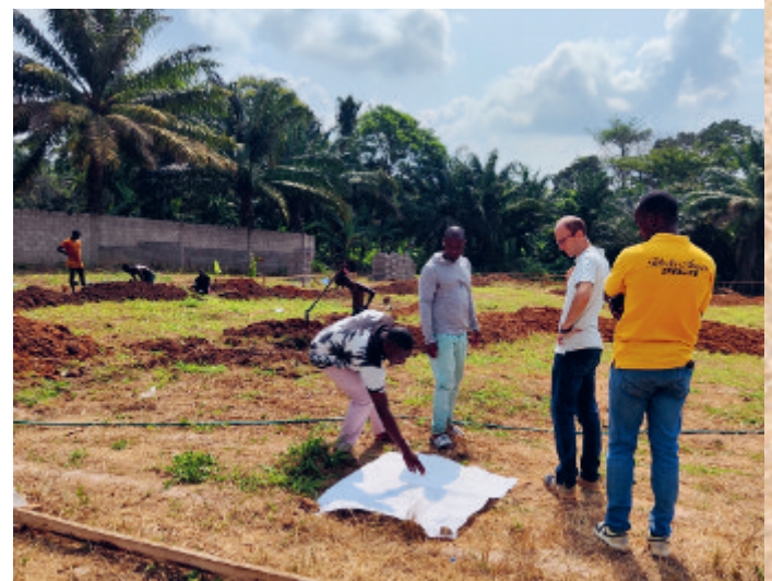
Am Anfang des Bauwerks - das Fundament
