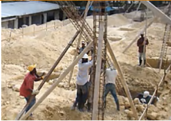
Aanbouw van de school
