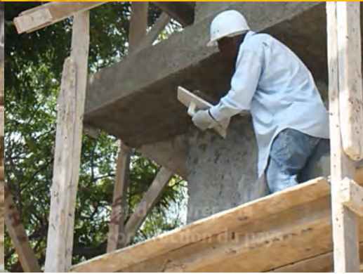
Metselen van een klaslokaal
