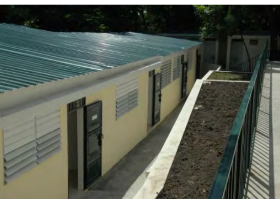
Zicht op de verschillende klaslokalen
